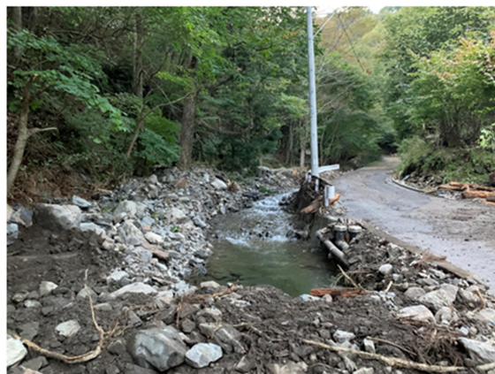
沢から流出した土石流が、沢を横断するように堆積している
