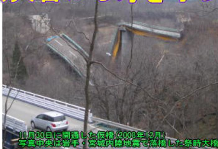
平成 20 年 6 月 14 日に発生した岩手・宮城内陸地震は、両県に甚大な被害をもたらしました。地すべり、急傾斜地の崩壊などの土砂災害が多いことが特徴です。岩手県内は、祭時大橋(一関市巖美町)の落橋が象徴的な被害でした。落橋の原因も橋の基礎地盤の地すべりと考えられています。
